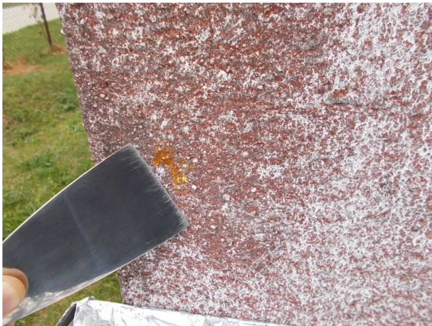
Obr. 21 Dezinfikovanou špachtlí obrousíme do záchytné hliníkové fólie vrchní vrstvy povrchové úpravy vzorkované konstrukce. Postupujeme šetrně tak, aby při odběru nedošlo k vážnějšímu mechanickému poškození vzorkované konstrukce.
