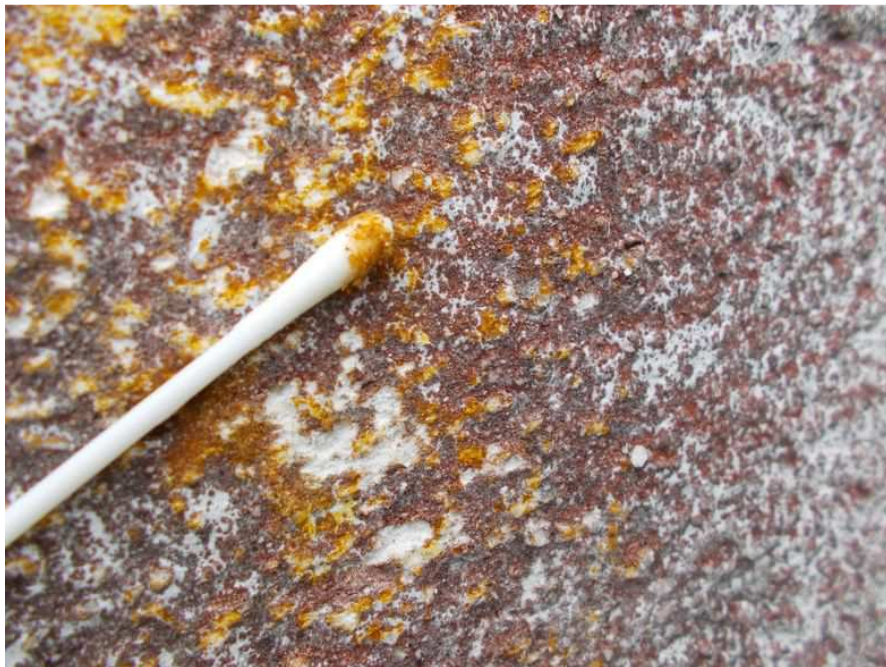
Obr . 27 Druhý stěr „B“ sbírá biotické kultury z obrusem zpřístupněných prohlubní a současně zachytí drobné částice povrchové úpravy, mechanicky narušené obrusem. Úspěšný odběr signalizuje zbarvení stěrového tamponu a viditelné částice povrchové úpravy.
