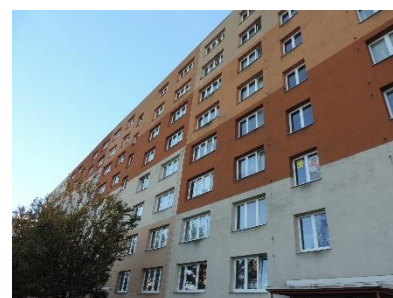
Obr. 1 – 3: Vzorová foto objektů napadených mikroorganismy v řádu nad cca 25 % plochy pláště fasády.
