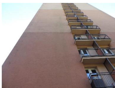
Obr. 1 – 3: Vzorová foto objektů napadených mikroorganismy v řádu nad cca 25 % plochy pláště fasády.
