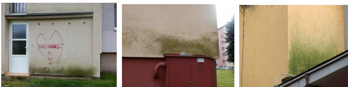
Obr. 14 – 16 příklady a důsledky zvýšeného ostříku vody.
