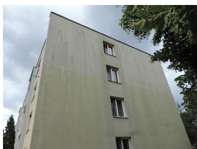
Obr. 1 – 3: Vzorová foto objektů napadených mikroorganismy v řádu nad cca 25 % plochy pláště fasády.
