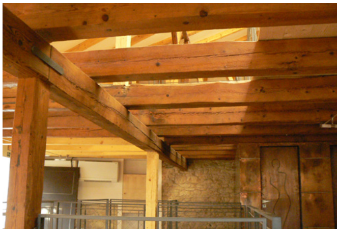
Realizace protipožárního nátěru FLAMGARD TRANSPARENT
