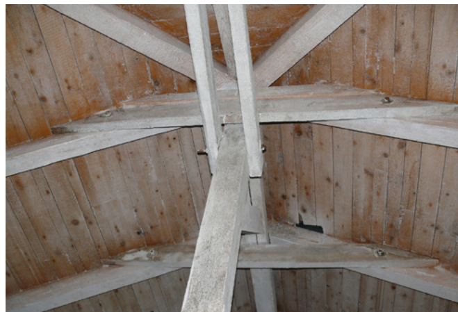
Realizace protipožárního nátěru FLAMGARD
